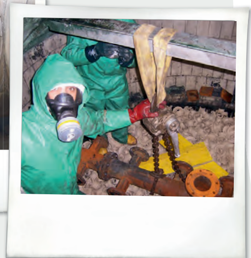
Eine Arbeit für Profis ist die Wartung eines Schwefelsäureofens – hier am Standort Pischelsdorf.
