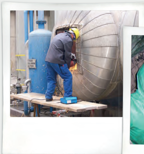
Eine Arbeit für Profis ist die Wartung eines Schwefelsäureofens – hier am Standort Pischelsdorf.
