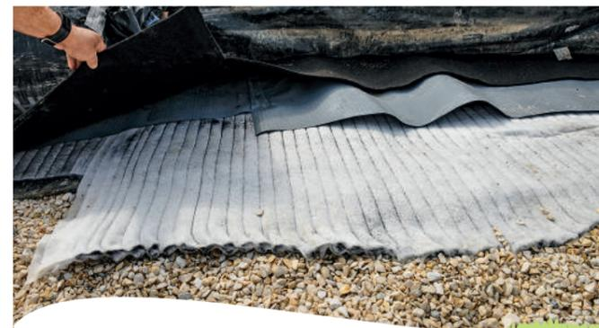
Mehrere Materialschichten dichten die Deponie ab, u. a. Aktivkohlematten.
