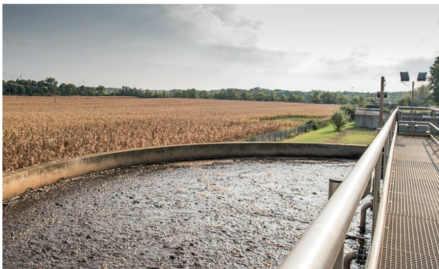
In Gols/Mönchhof wird das Abwasser in zwei Stufen biologisch gereinigt – eine Besonderheit. Die mobile Presse bereitet den Klärschlamm für die Kompostierung auf (unten).
