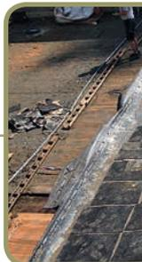
Die Mure hatte den Gummi des Schlauchwehres stark beschädigt. Wie stark, wurde erst jetzt klar: Das Team lokalisierte ein großes Leck und über 60 kleinere Löcher, durch die das Wasser des Schlauchwehres ausgetreten war. Die Schäden zu finden, funktionierte wie bei einem Fahrradpatschen: In den kaputten Gummi wurde Druckluft gepresst. Wo sie wieder austrat, befanden sich die Löcher.
