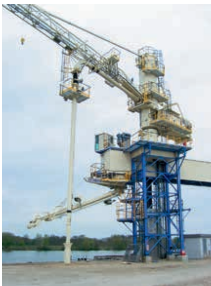
Bis zu 400.000 Tonnen transportiert der Förderturm pro Jahr vom Schiff ins Silo.
