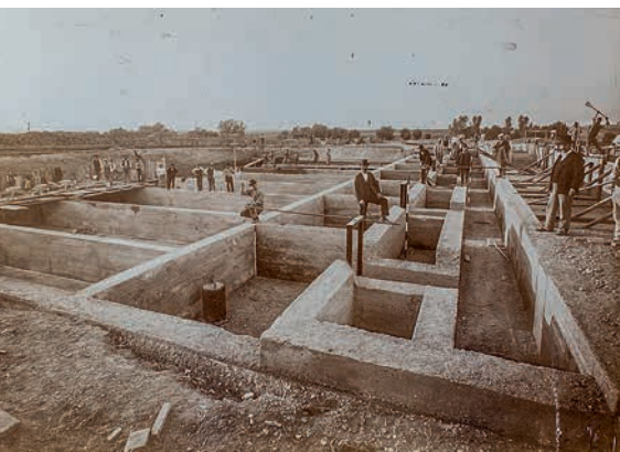
Die Kläranlage wurde ab 1898 in Handarbeit errichtet.
